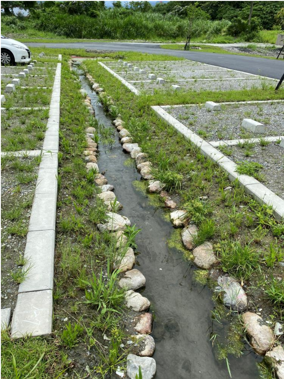
停車場之 湧泉導水 及排水道
