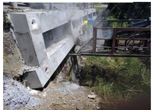
補強格梁岩釘深度查驗
