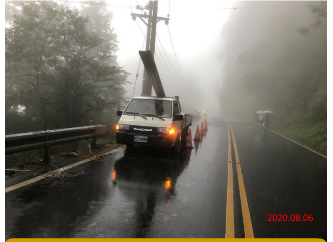
濃霧影響工進，警示燈號確保安全
