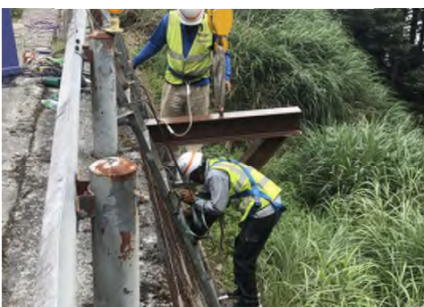
鋼構假組立確認
