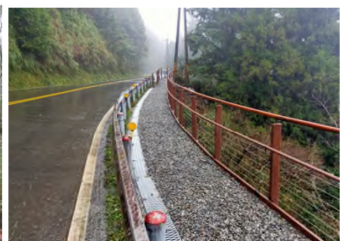
鋪面級配鋪設確認
