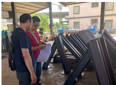
鋼構工廠組立查驗
