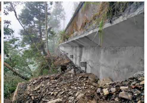
基礎混凝土澆置後查驗
