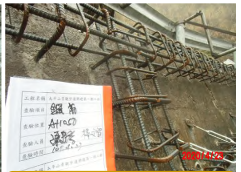
補強格梁鋼筋查驗
