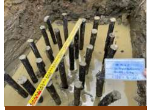
木樁打設查驗
