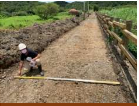
產業通道開挖
