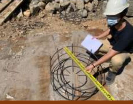
單元塊鋼筋組立
