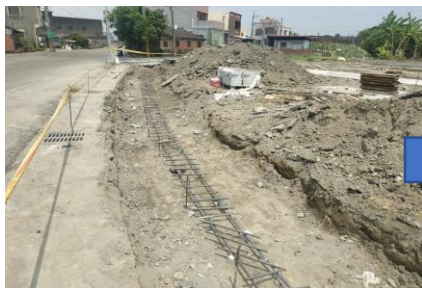
①磚牆基礎施作
