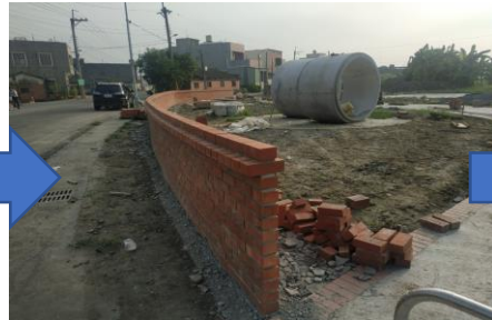
③磚牆牆身清水磚施作
