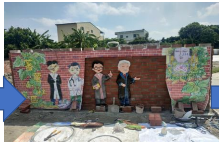
⑦1:1比例出圖現場施作
