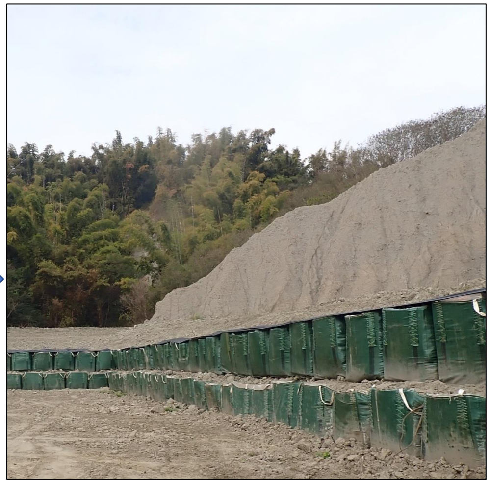
H=2m基腳護坡
