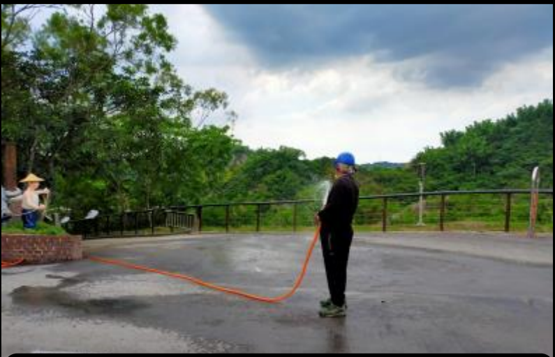
工區外灑水降塵
