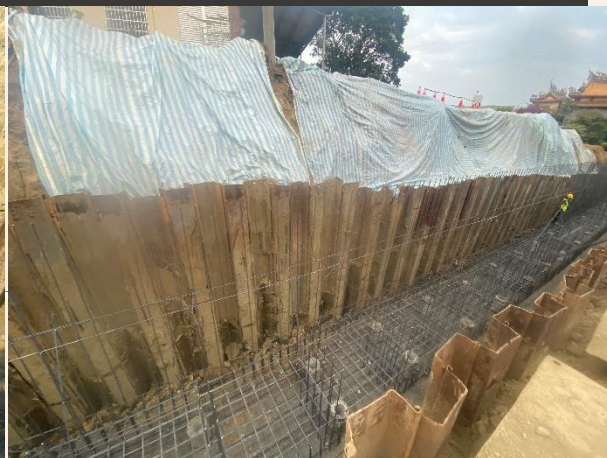
露天開挖打設鋼軌樁及鋪設帆布防沖蝕
