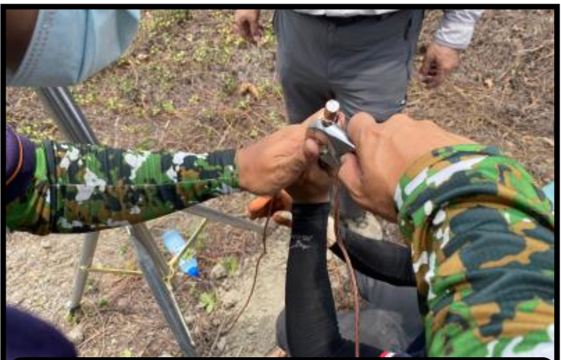
微氣象監測系統安裝
