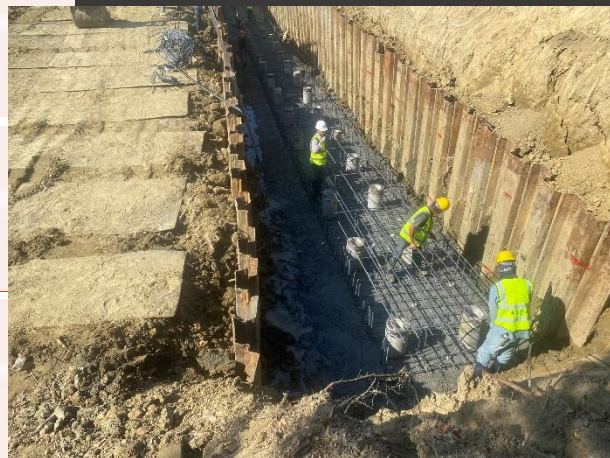
露天開挖打設鋼軌樁及鋪設帆布防沖蝕
