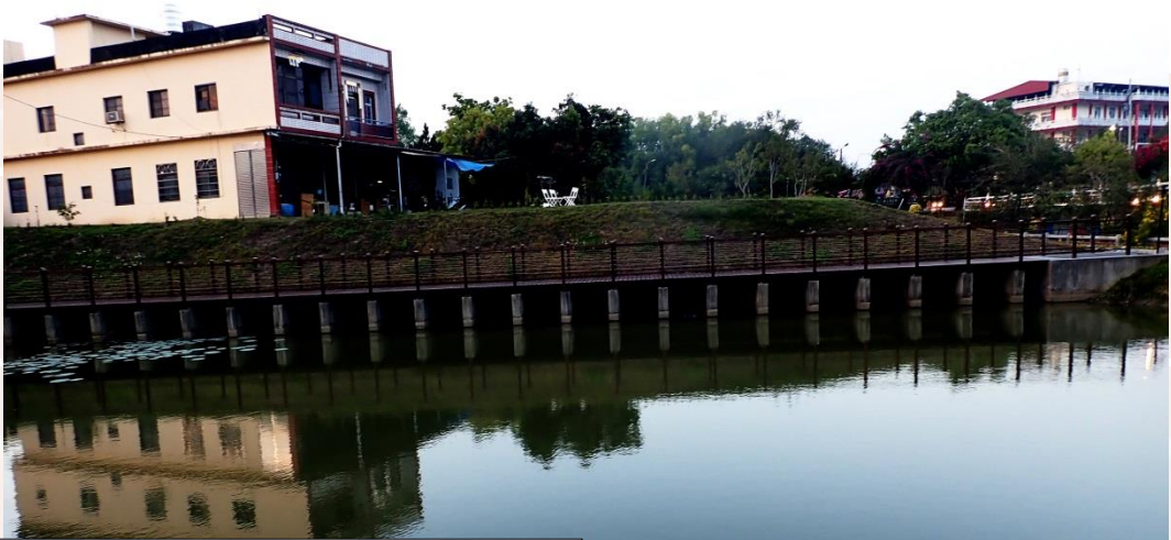
疏濬+裸露坡面植生
