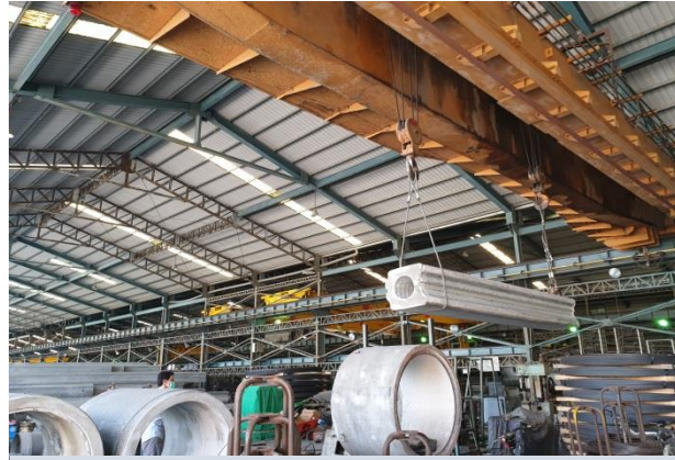
版樁完成吊放
