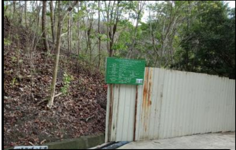
施工告示牌檢查
