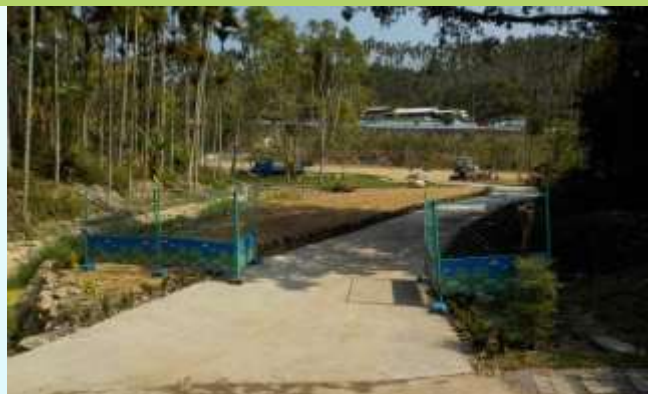
工區大門管制
