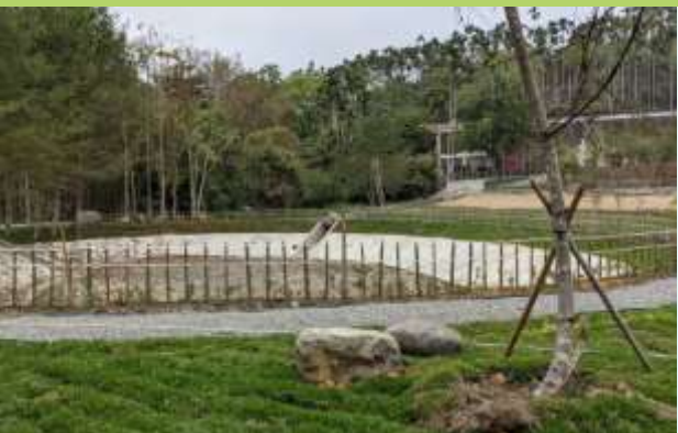
高差大於2m設置護欄
