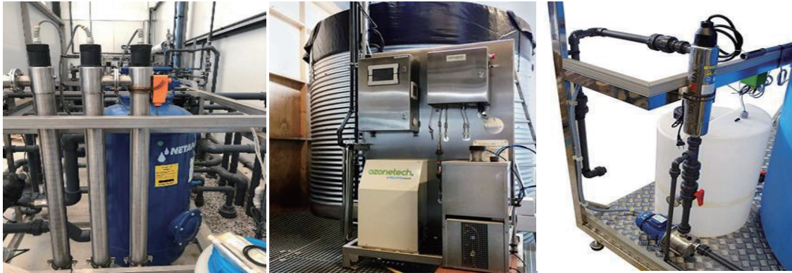
▲ 圖 4. UV 殺菌機 (A)、臭氧產生器 (B) 及加氯器 (C)
