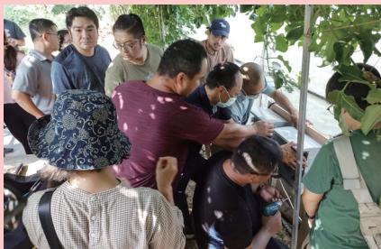
▲示範安裝控制電箱
