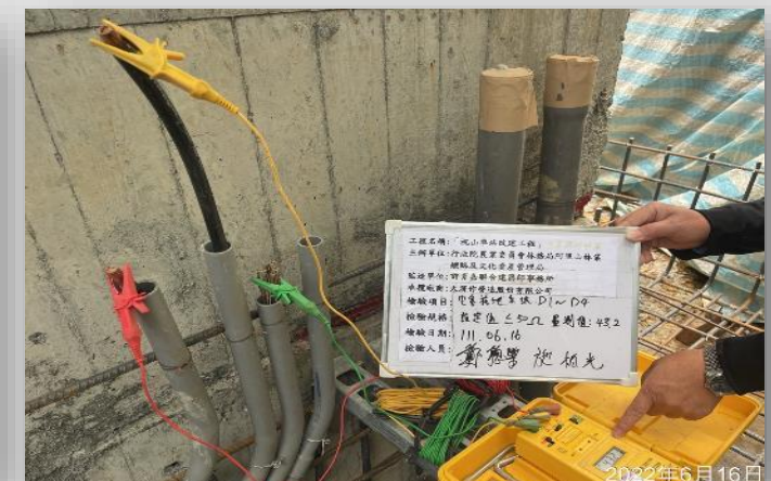
電氣接地量測
