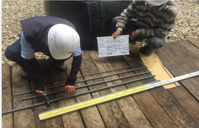
鋼筋取樣查驗
