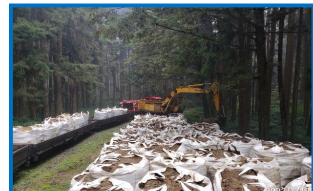
土方運抵後吊至指定位置
