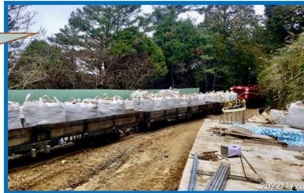
挖掘土方裝袋以火車載離工地
