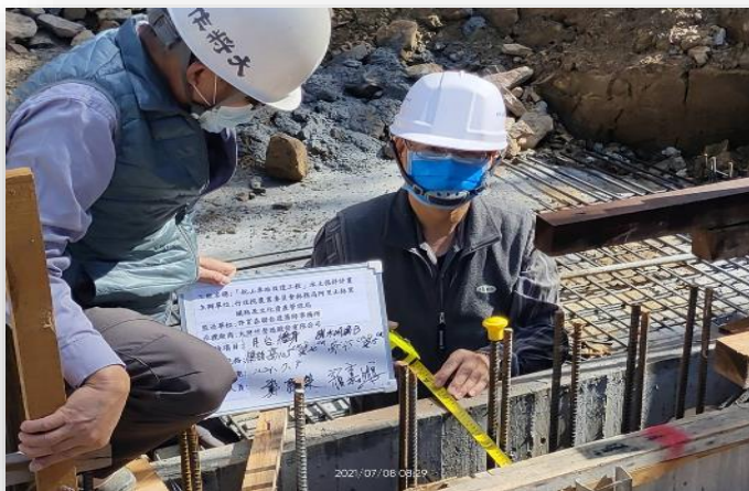
模板施工查驗
