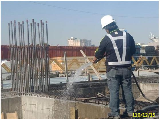
灑水養護避免產生結構裂縫
