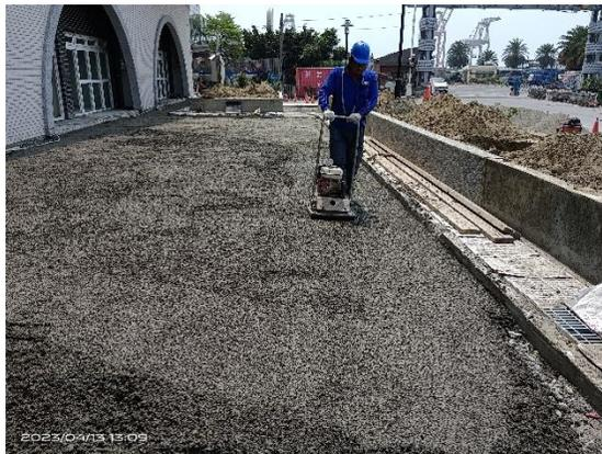
透水性鋪面-透水性混凝土
