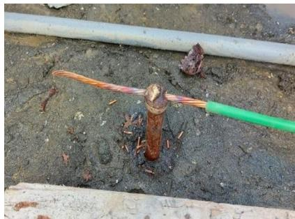
接地焊點牢固施工
