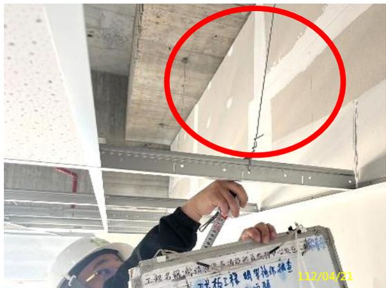
天花板耐震計算、吊筋設置
