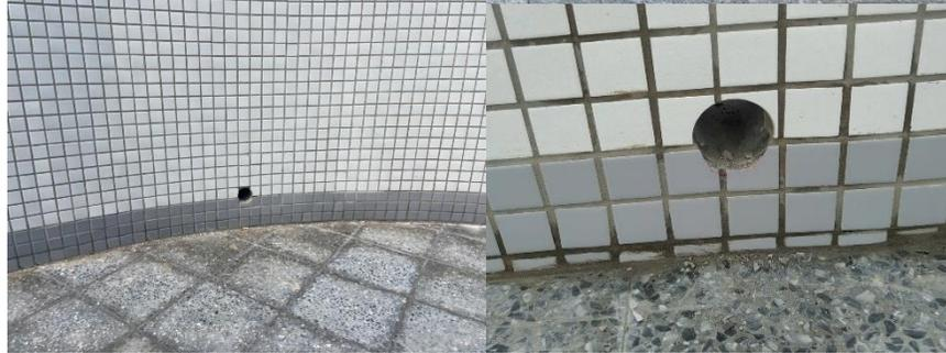
女兒牆溢水孔(溢水孔高度15公分)
