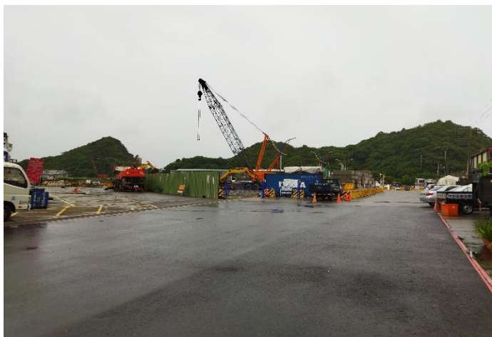
▲ 地震後工地巡查
