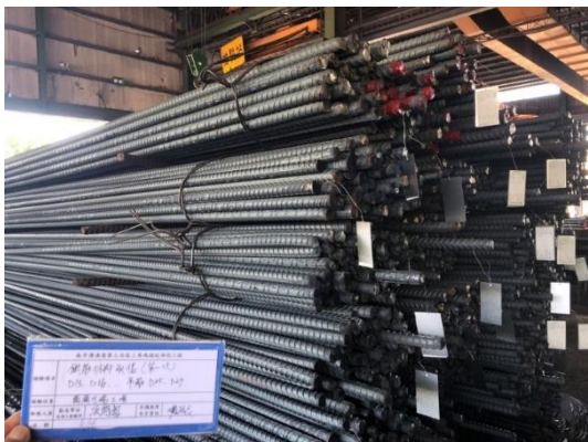
▲鋼筋材料進場自主檢查
