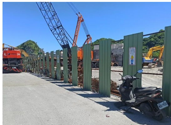
▲ 工區圍籬拆除
