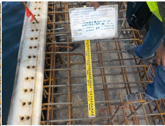
▲冠牆鋼筋綁紮自主檢查
