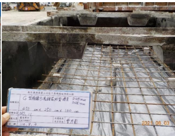
▲方塊鋼筋綁紮自主檢查
