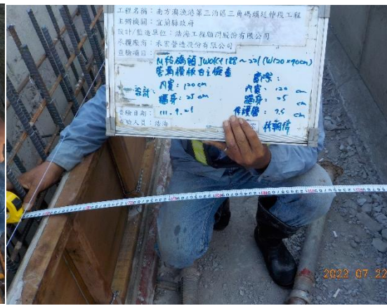
▲管溝模板組立自主檢查
