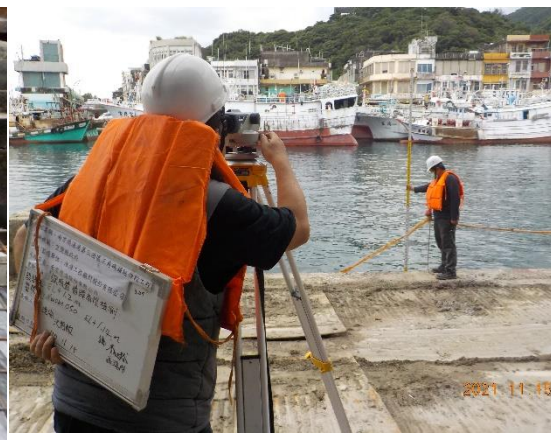
▲鋼板樁測量自主檢查
