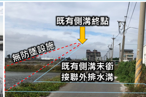
D 既有側溝未銜接聯外排水溝
