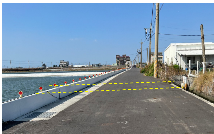
B 新設排水溝銜接聯外排水完工照
