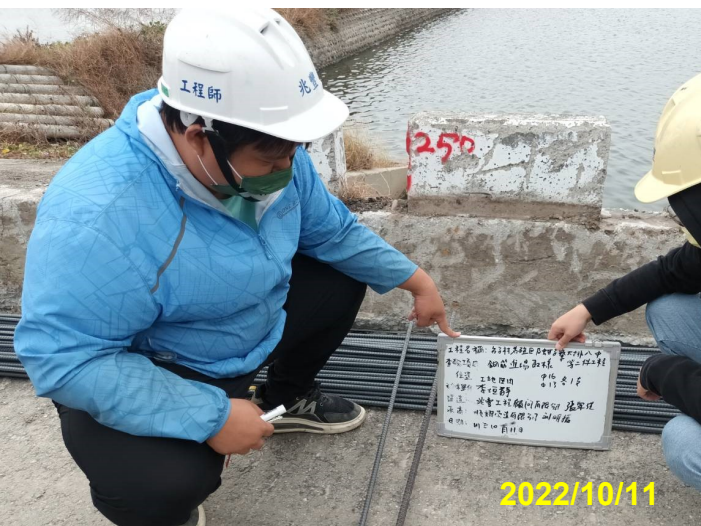
鋼筋材料取樣
