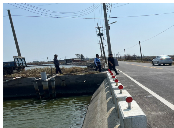
C 護岸改善後現況照片
