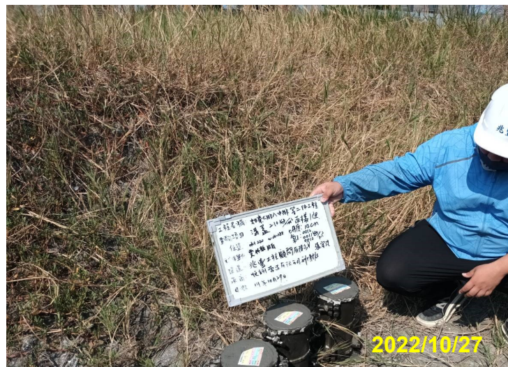
混凝土材料取樣
