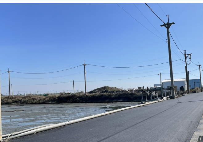
路面鋪設及排水溝完工照
