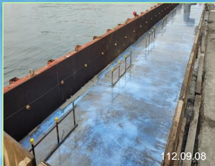
混凝土養護-養護劑
