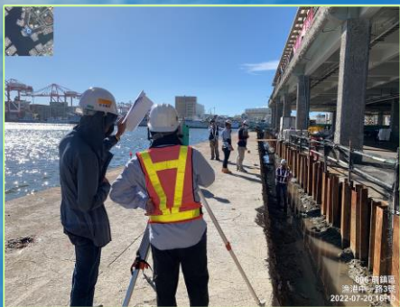
鋼板樁高程確認
