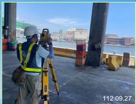
開挖安全監測
