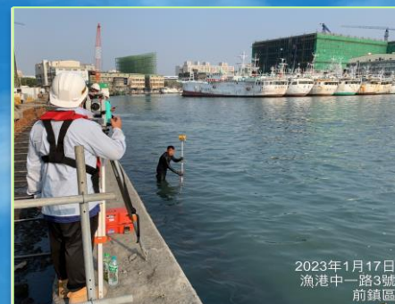
施拉後確認鋼板樁位移量
