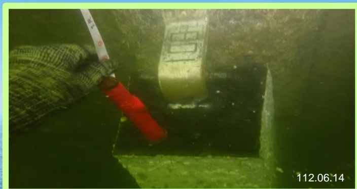
A型鋼板樁安裝鋁陽極塊
