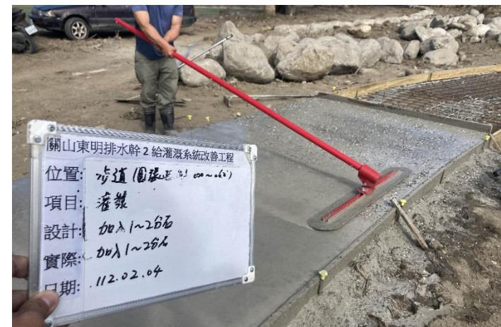
初凝階段(膠化期初期)加入礫石/進行粉光
