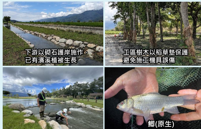
施工生態保育措施抽查
