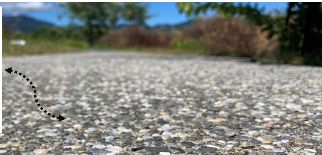
初凝階段(膠化期初期)加入礫石/進行粉光
