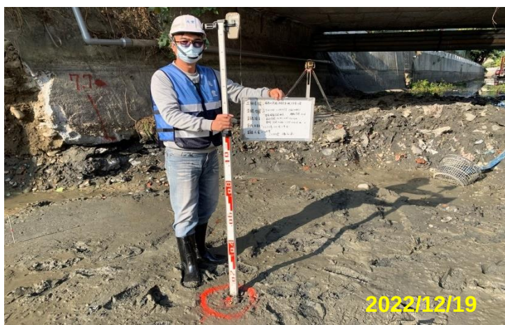
開挖高程檢測
