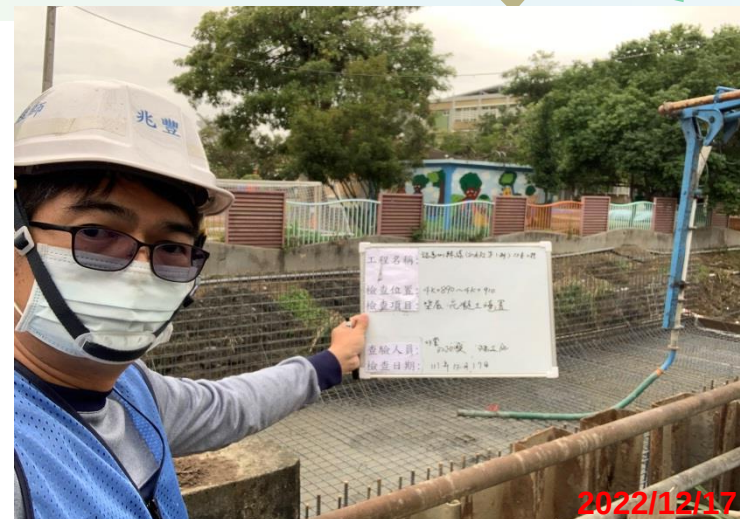
底版混凝土澆置
