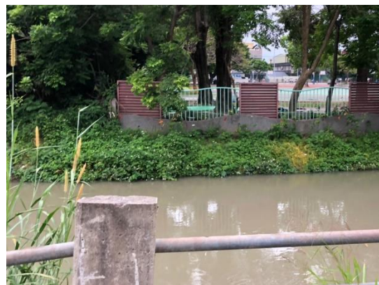
B 腹地狹小 既有圍牆老舊
