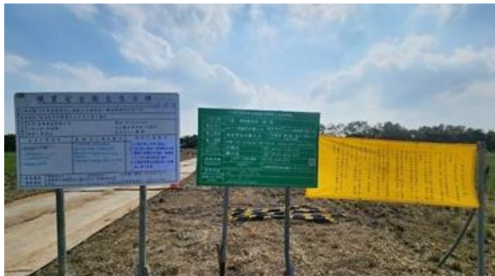
工程告示牌設立
