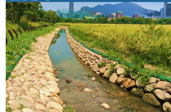
■ 塊石孔隙及生態管
