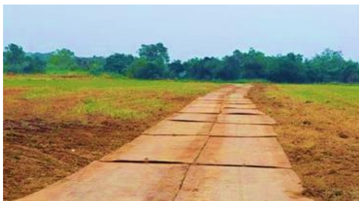
施工便道全面鋪設鐵板
