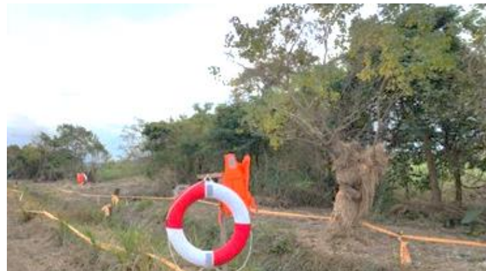
施工範圍管制及救生圈
