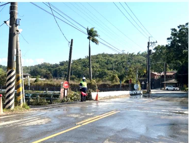
工區出入口安全管制
