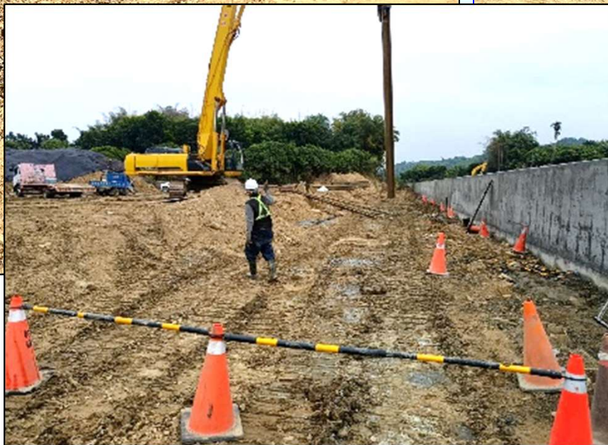
鋼板樁減少開挖面積，限縮工程開挖範圍
