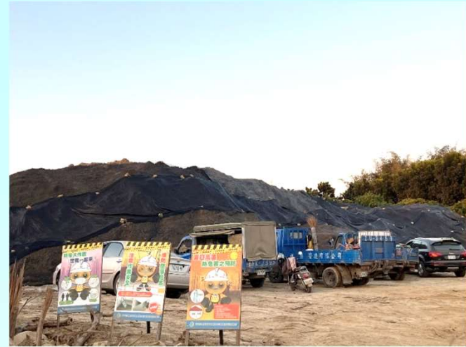
土方堆置區覆蓋
