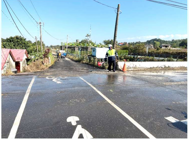
工區周邊道路清洗
