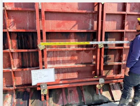
模板組立抽查
