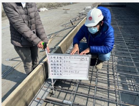
模板組立抽查
