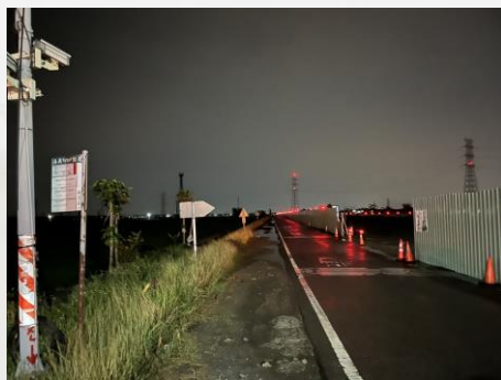
夜間警示設施
