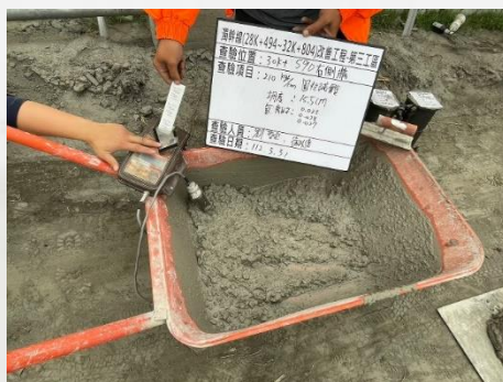
混凝土氯離子試驗
