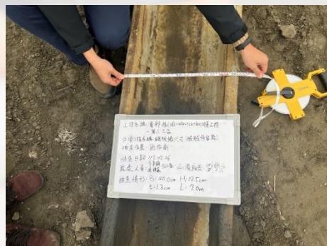
鋼板樁尺寸抽查
