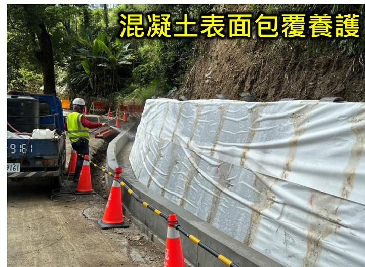
混凝土表面包覆養護
