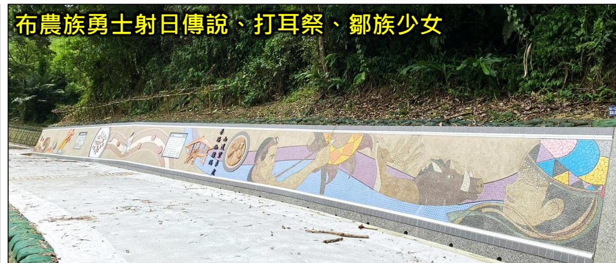
使用振石子、馬賽克拼圖、陶板等材質拼貼美化擋土牆
