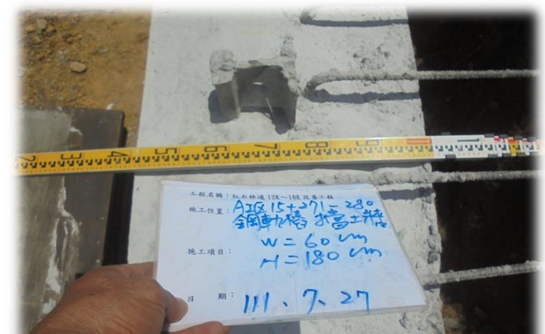
鋼軌樁擋土牆完成面查驗
