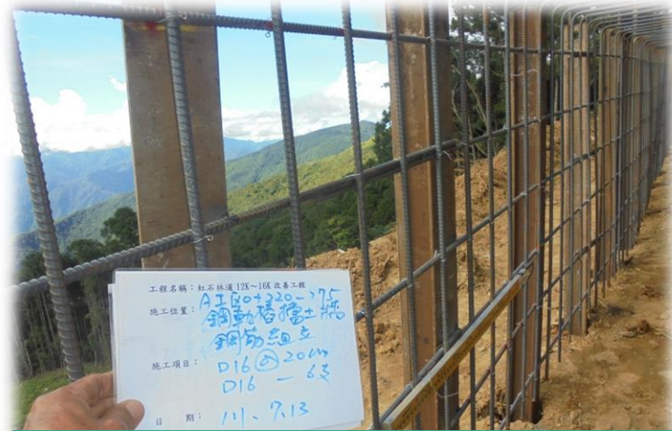
擋土牆鋼筋組立尺寸查驗
