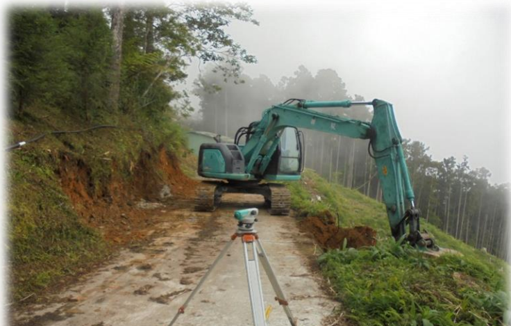
高程測量放樣檢測
