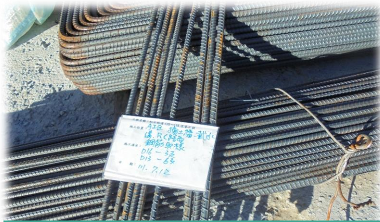
鋼筋材料取樣
