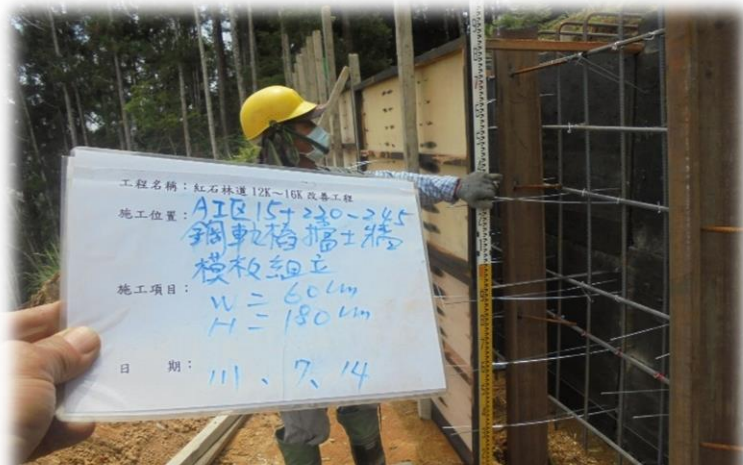
鋼軌樁擋土牆模板組立查驗
