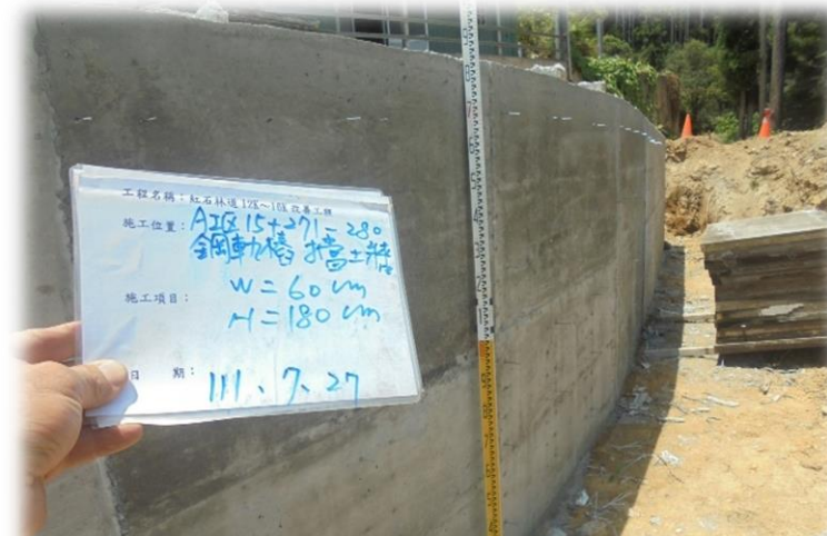
鋼軌樁擋土牆完成面查驗
