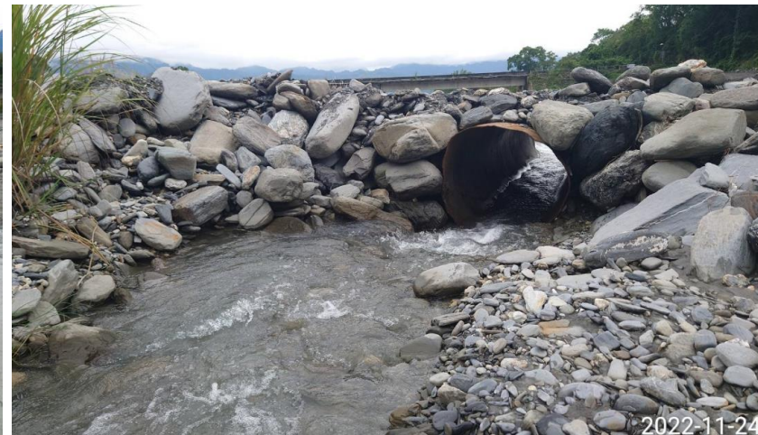
過水路處加設涵管降低溪水濁度
