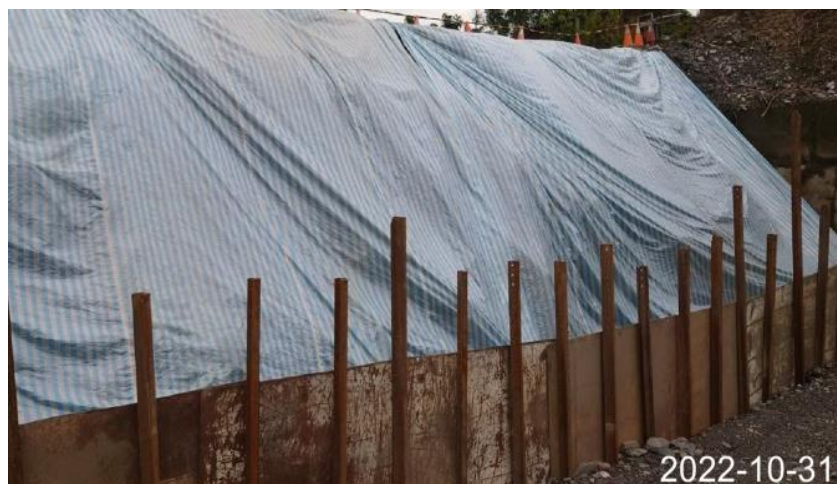
裸露坡面覆蓋帆布
