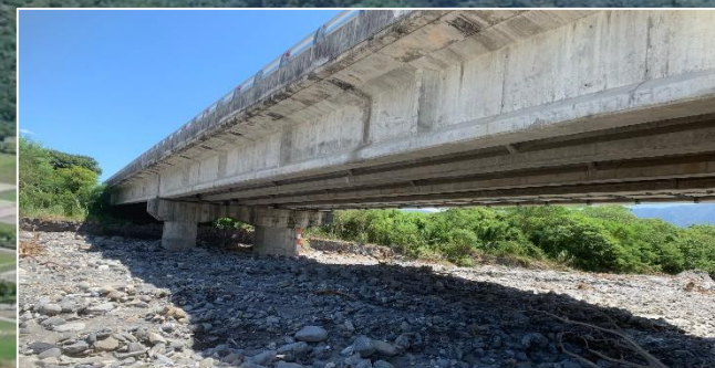
加鹿溪橋(預力L=100m垮距3垮 路寬12.5m)
