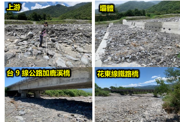
112.8.28 杜蘇芮颱風後土砂及構造物調查
