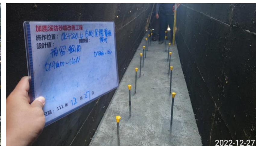
預留鋼筋套頭檢查
