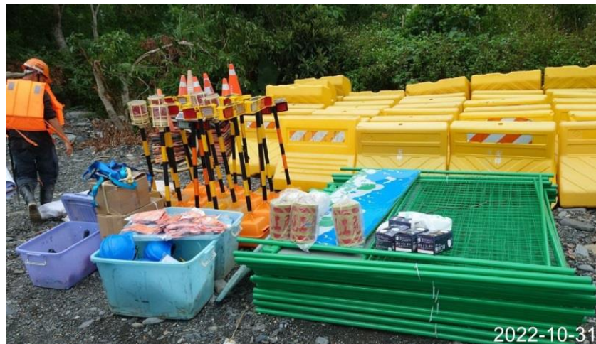
勞工安全設施進場檢查
