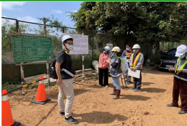
工地危害告知
