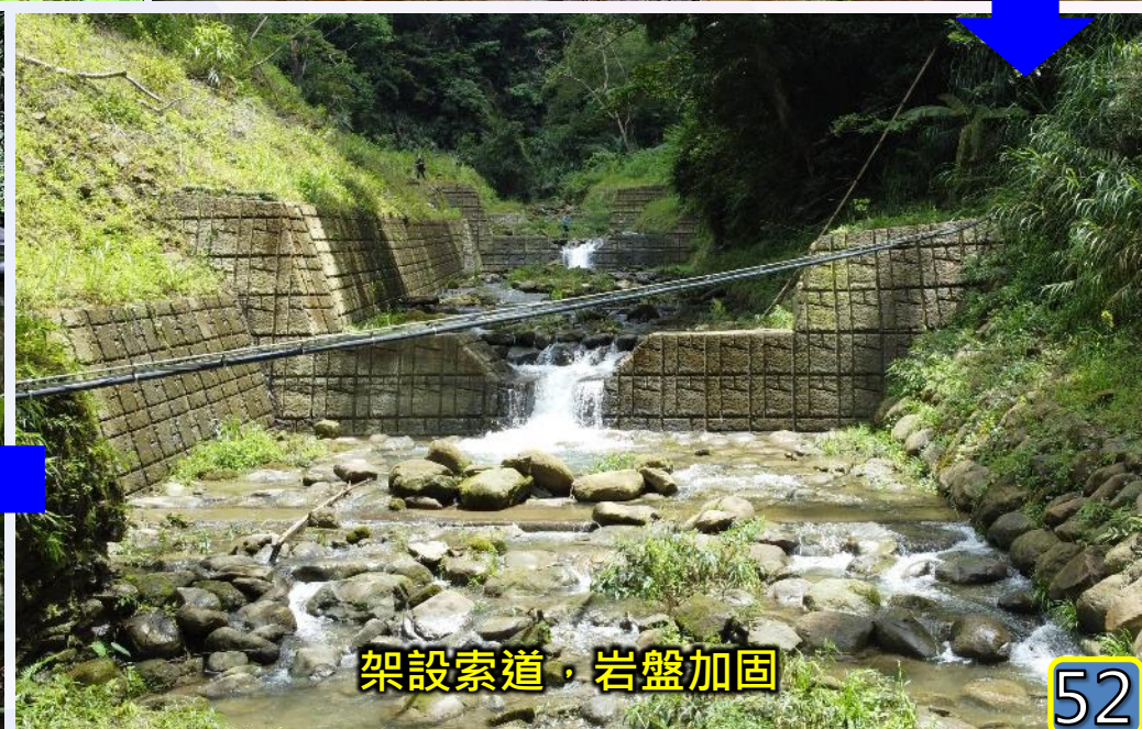
鋼纜結合HDPE管架設
