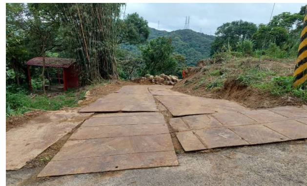
工區鋪設止滑鐵板
