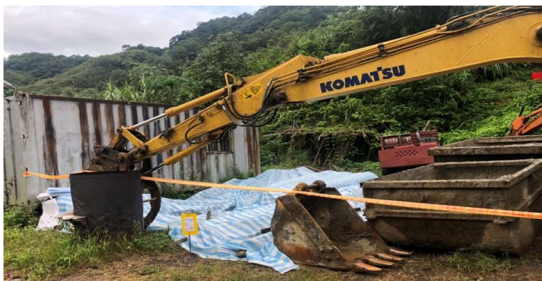
施工材料機具堆置區
