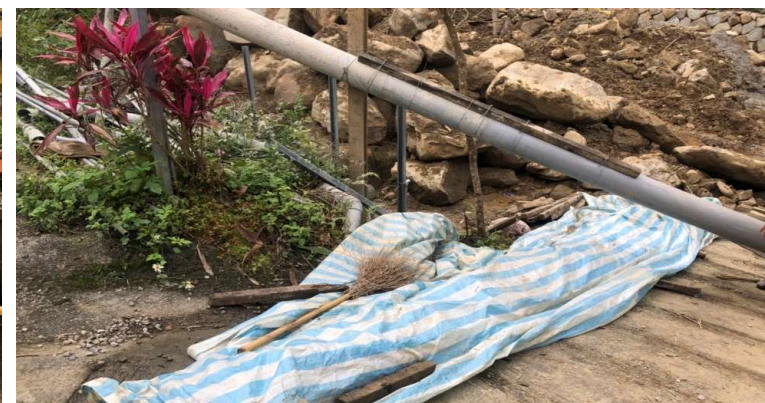
鋼筋材料帆布覆蓋
