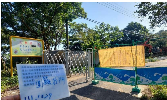
工地管制大門
