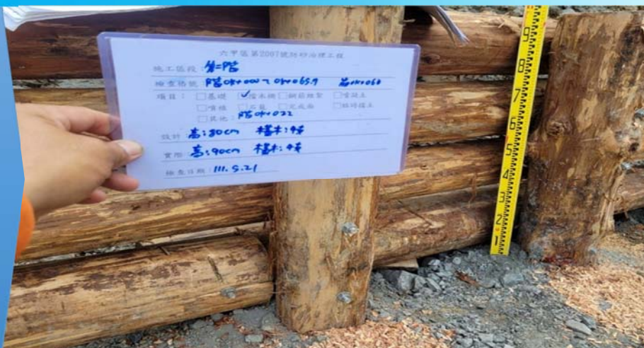
擋木柵完成檢查
