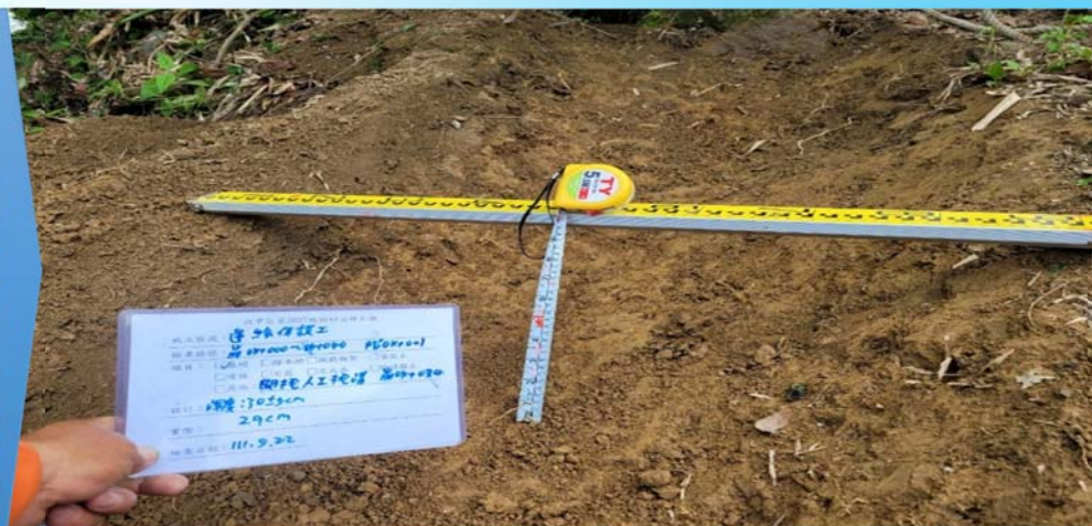
人工挖溝檢查
