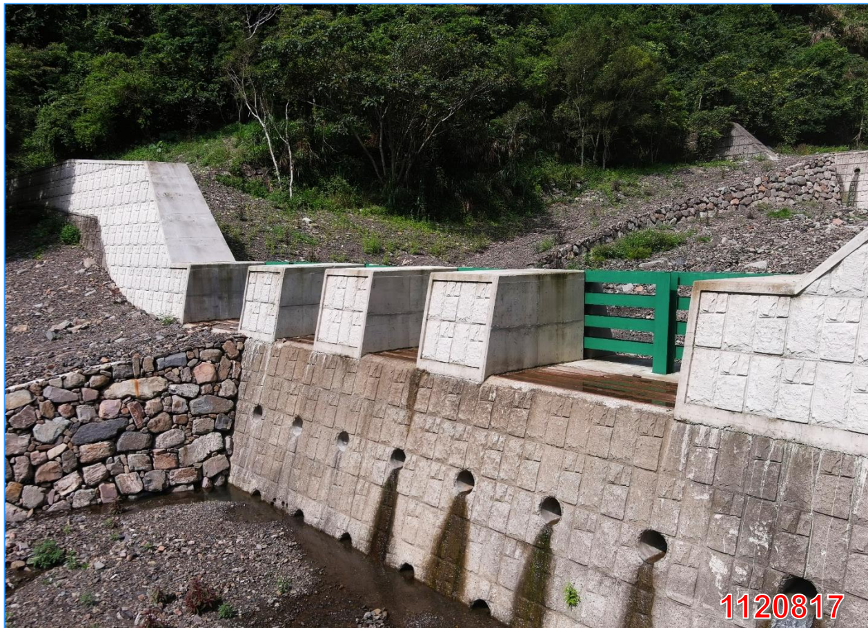
5號壩新舊壩銜接平整
