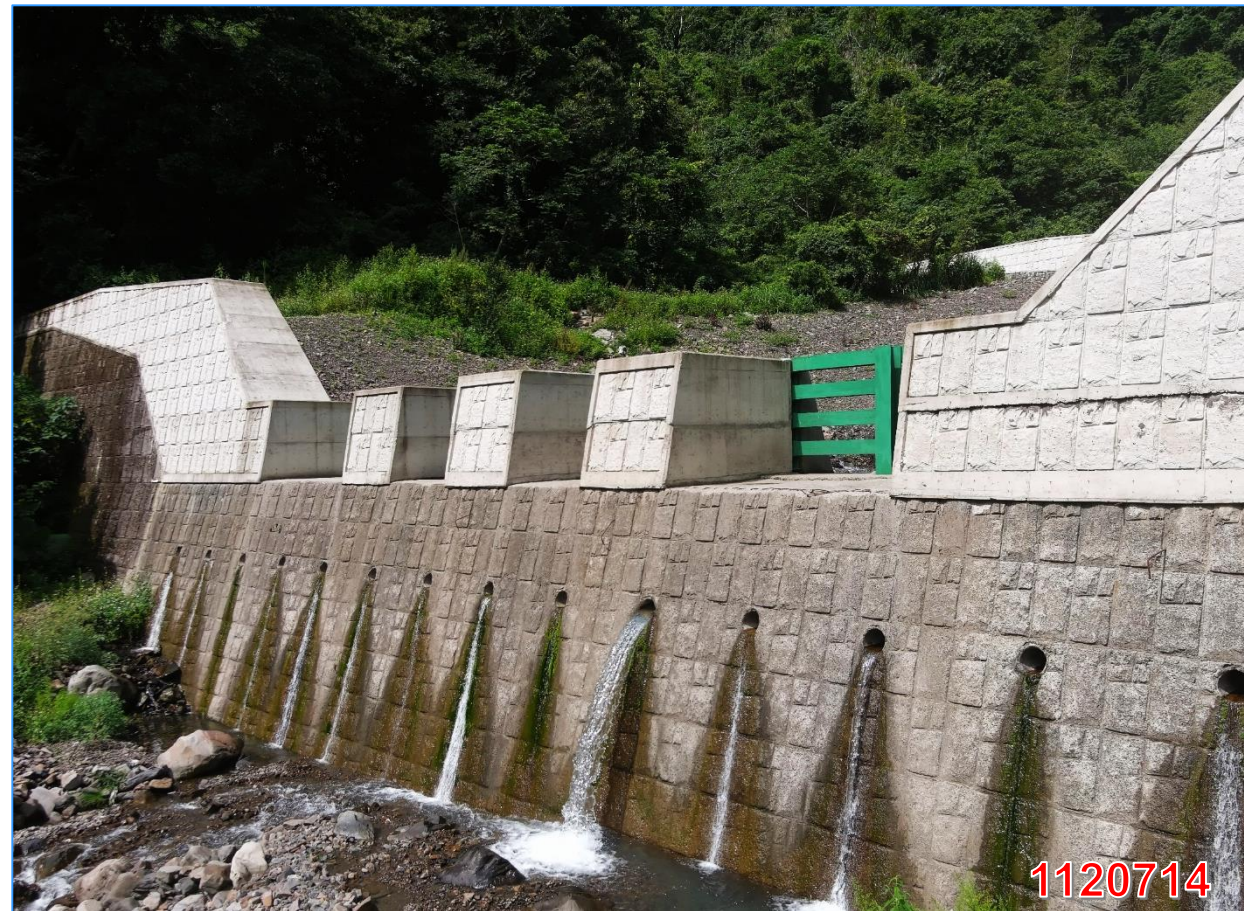
3號壩新舊壩銜接平整
