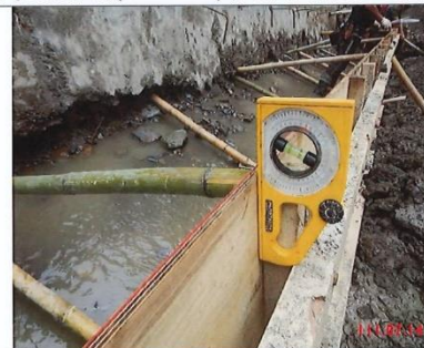
#3 防砂設施加高(OK+465.88)順水右岸牆體第一層模板斜率
