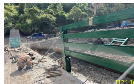
H型鋼施作
