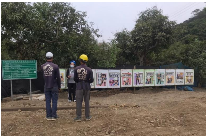
工地危害告知
