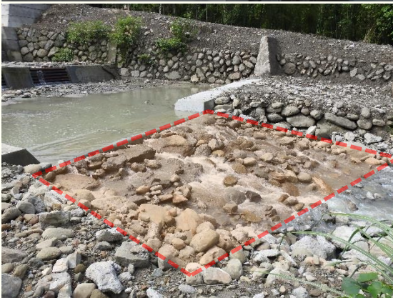
既有潛壩下游新增 拋塊石斜坡 (112/6/8)
