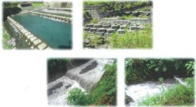
112年度南投分局水土保持構造物巡查計畫 期中報告書
