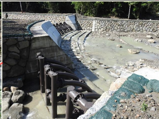
鋼管壩下游變更為 階梯式跌水 (112/6/8)
