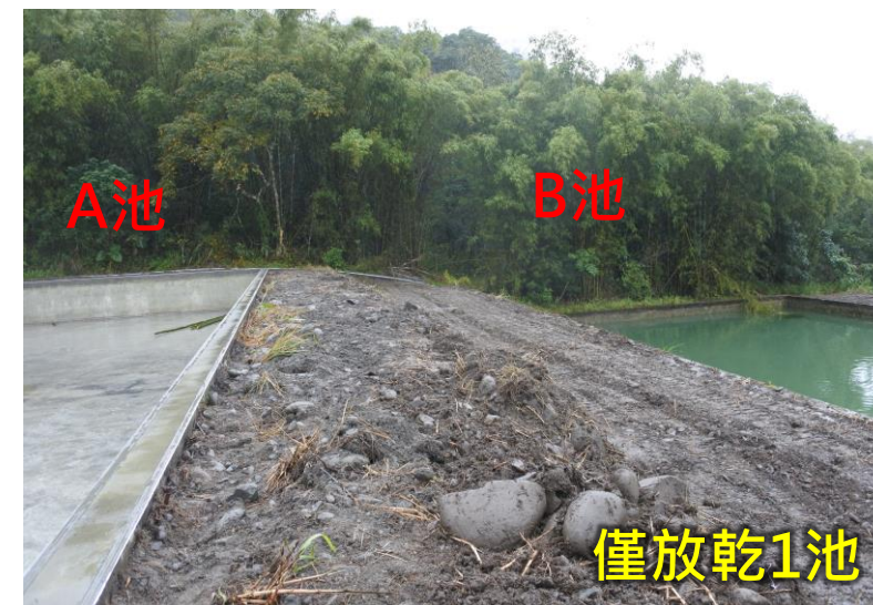
配合地方用水調整施工
