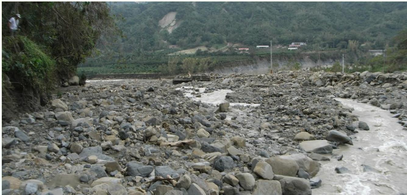
**洪水災害嚴重，造成南179線道路中斷、橋樑損壞及農地流失，危及民眾生命財產安全**
