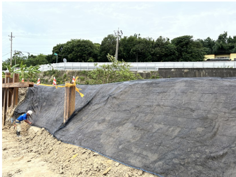
坡面保護措施
