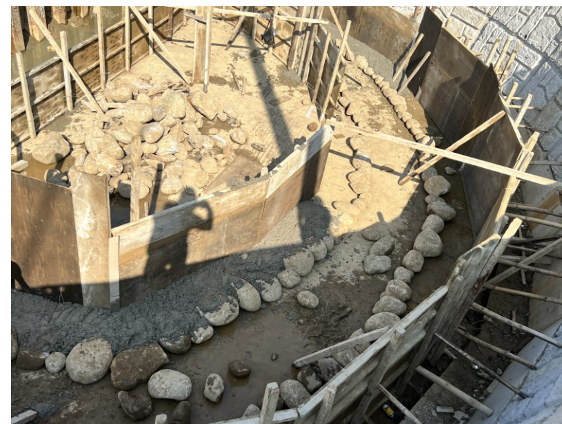
石籠材料回收再利用 (滯洪緩衝區之基礎)
