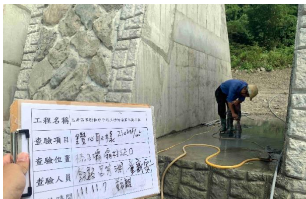
混凝土鑽心取樣
