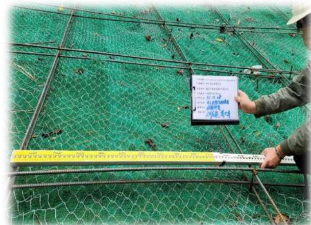
樑框鋼筋綁紮檢查
