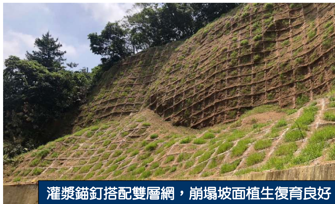
菱形網及抗沖蝕植生網雙層網保護，可避免逕流沖刷坡面及加速植生
