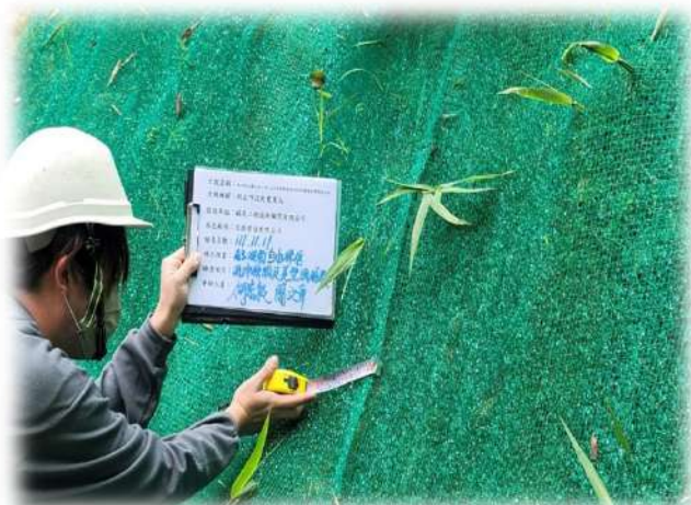
抗沖蝕網網材鋪設檢查
