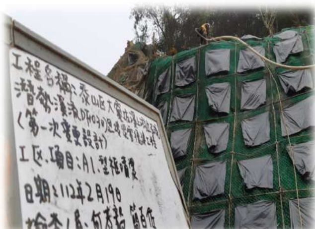
樑框噴凝土檢查
