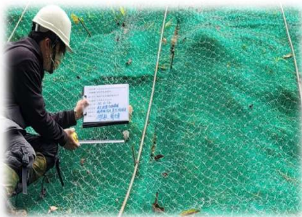
菱形網網材鋪設檢查
