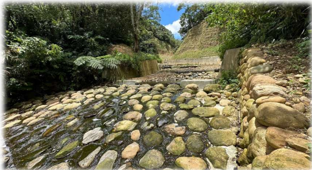
固床工表面鋪排塊石減少使用混凝土
