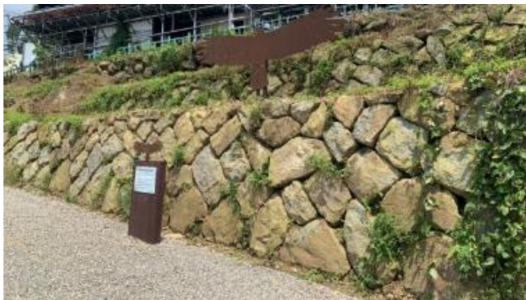
耆老及師傅手工開挖、選石、砌石，用豐富砌石經歷重塑現地砌石地景
