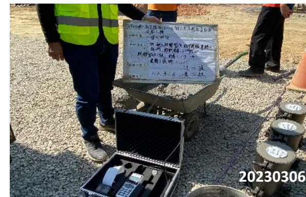
2 混凝土氯離子檢測
