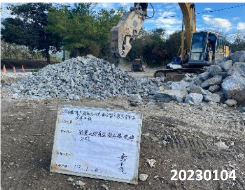
2 混凝土塊破碎粒料化
