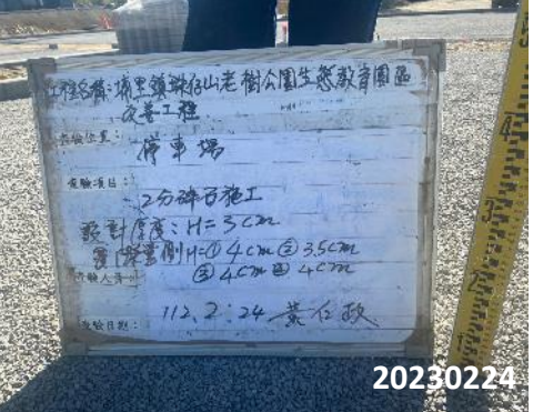
5 透水地坪鋪設2分碎石厚度、平整度
