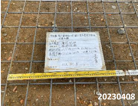
10 壓花地坪鋼筋綁紮間距20cm
