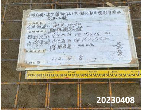
9 刷毛地坪鋼線網鋪設交疊35cm
