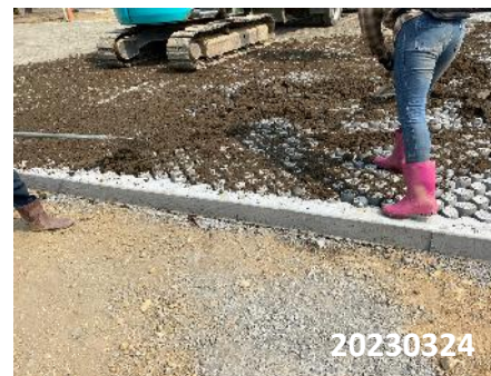
護 孔 洞 回 填 客 沃 土
