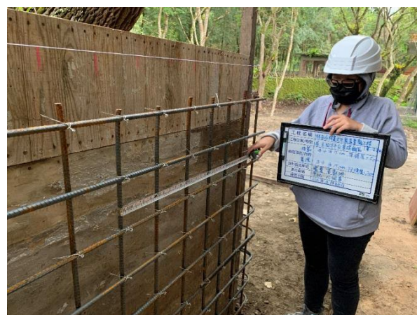
鋼筋工程施工抽查
