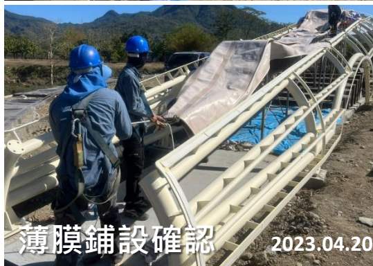
薄膜鋼構確認 2023.04.13
