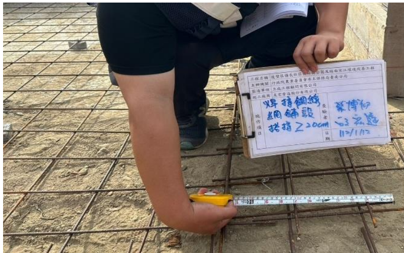
銲接鋼線網搭接長度抽查
