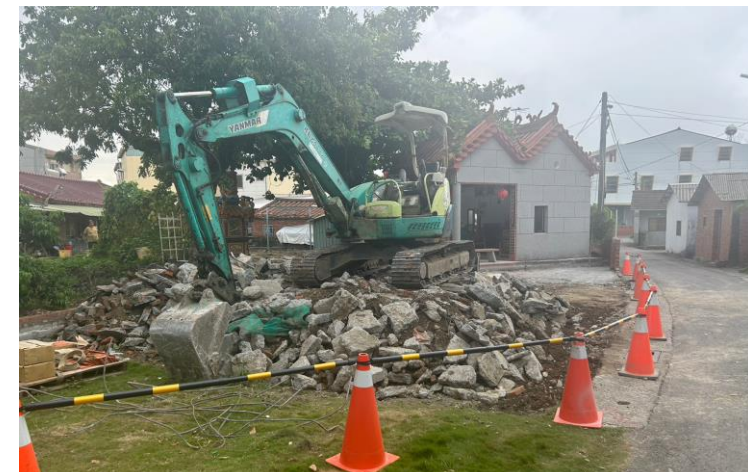
施工中加強安全措施
