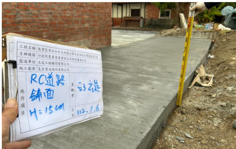
混凝土厚度鋪面
