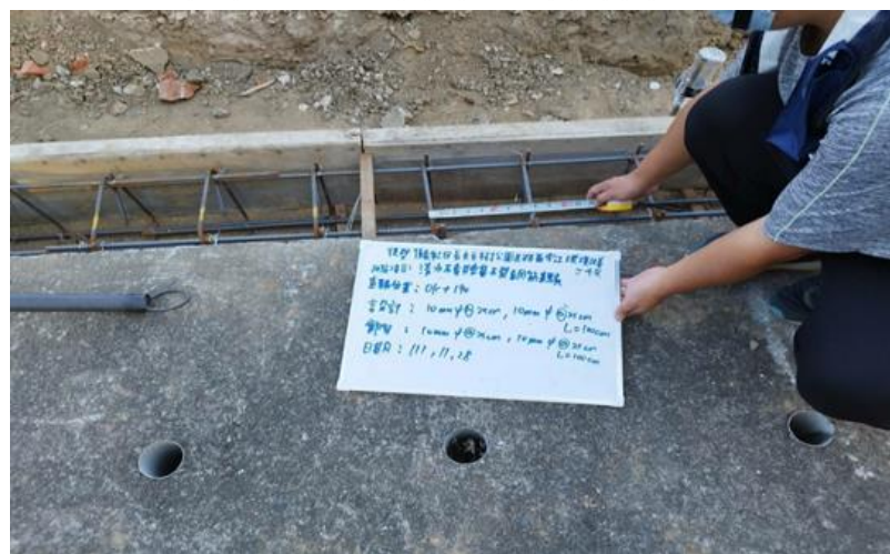
鋼筋尺寸及間距厚度
