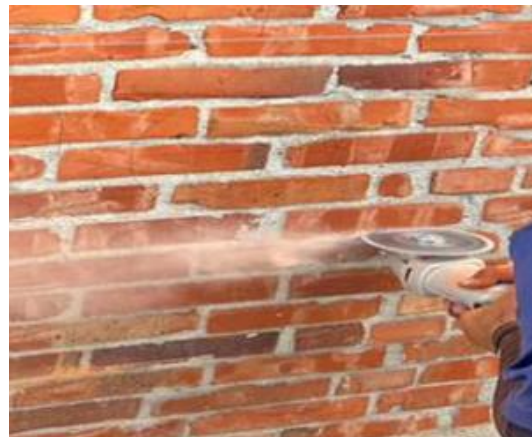
切割機具切溝槽
