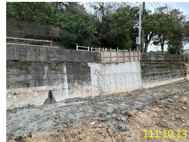
3.混凝土鋪設基礎
