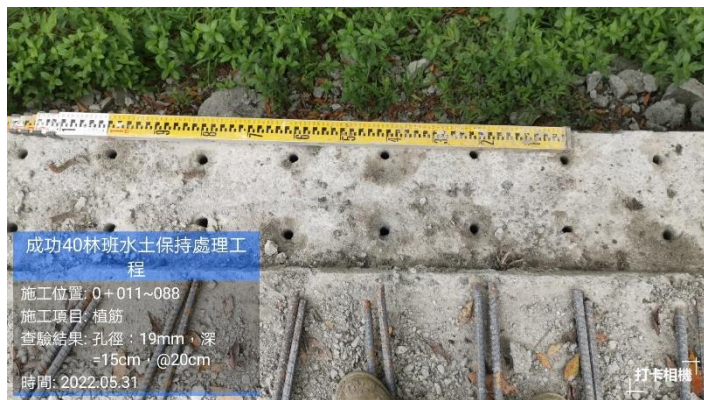
植筋鑽孔間距檢查
