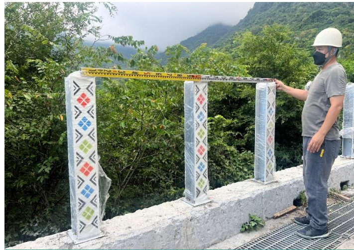
護欄鋼支柱組立尺寸查驗
