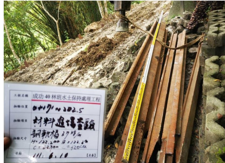
鋼軌材料進場查驗
