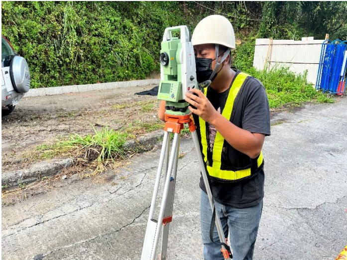
高程測量放樣檢測
