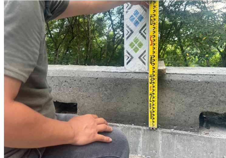
護欄基座完成面查驗
