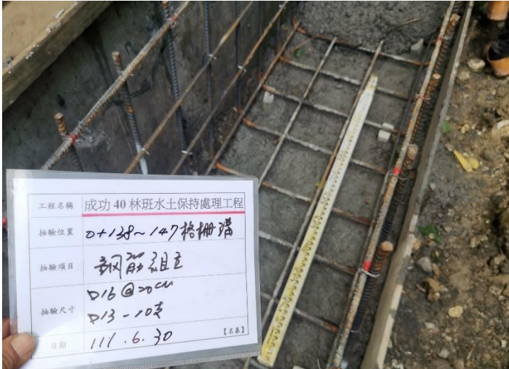
鋼軌樁擋土牆基礎查驗
