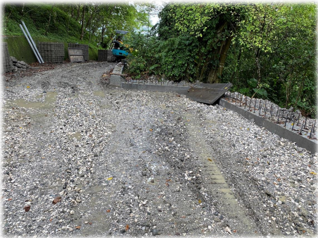
大型機具施作過程迴避並保全大樹-白榕，未傷及樹體
