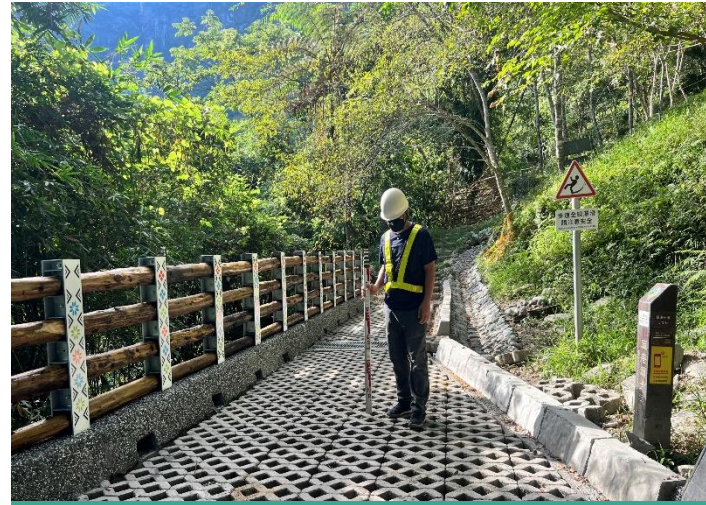
連鎖磚修復完成面查驗
