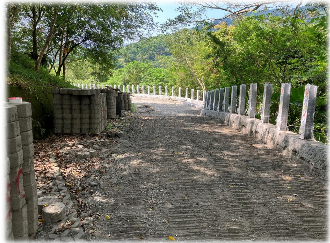
材料皆堆置於既有施工範圍內，未影響道路周邊既有植被
