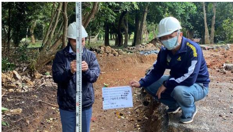
放樣開挖確認
