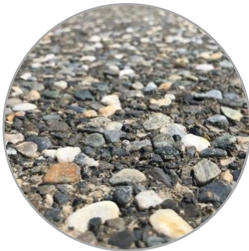
洗露骨材鋪面
