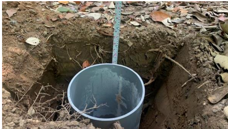
護欄柱基礎開挖深度確認
