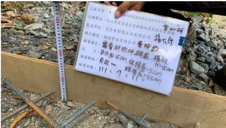
洗露骨材鋪面鋪設厚度查驗
