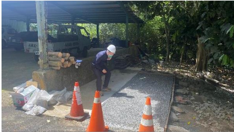
洗露骨材鋪面試做確認
