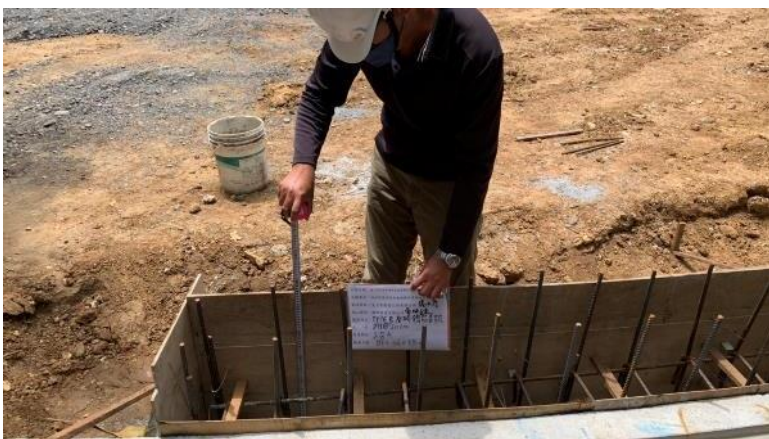
模板組立檢查
