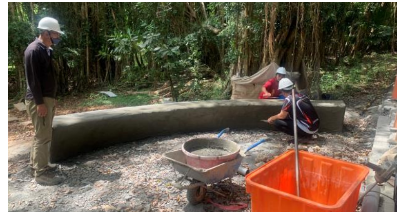
座椅施工中查驗
