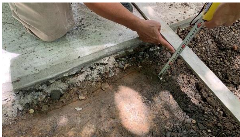
泥結碎石鋪面厚度查驗
