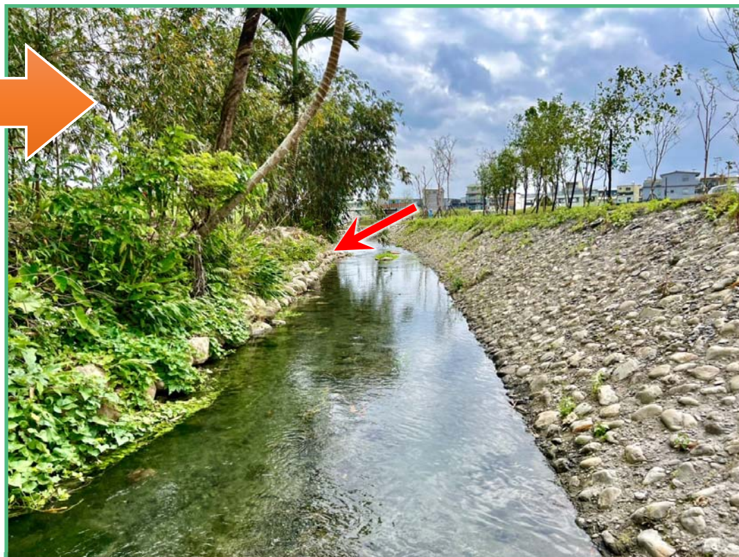
完工後 於湧泉溝左岸坡腳排塊石基礎保護工，防止掏空
