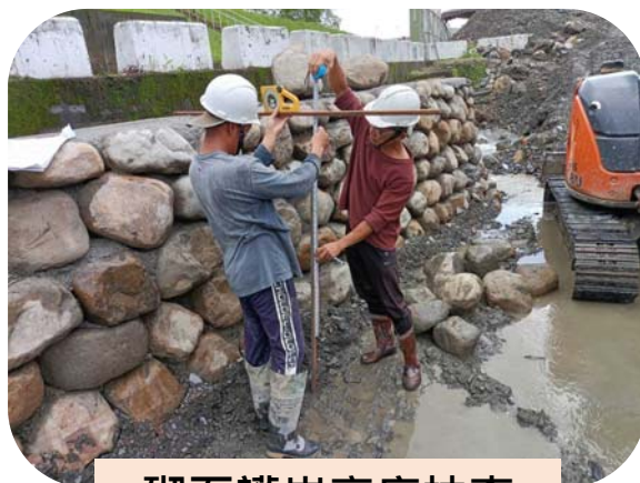
砌石護岸高度抽查
