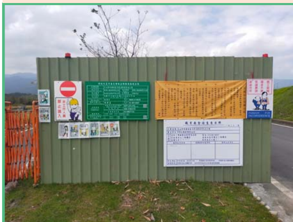
工程告示牌及職業安全衛生告示牌
