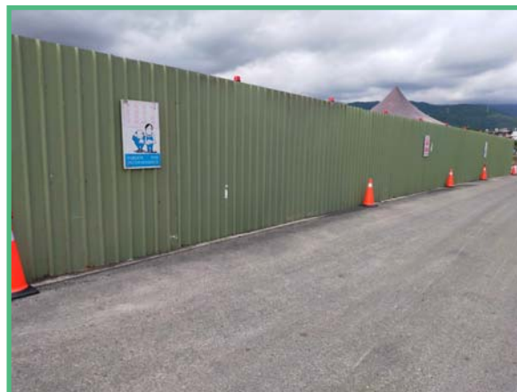
施工圍籬及警示燈設置
