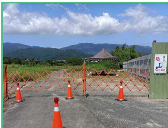
工區管制大門設置
