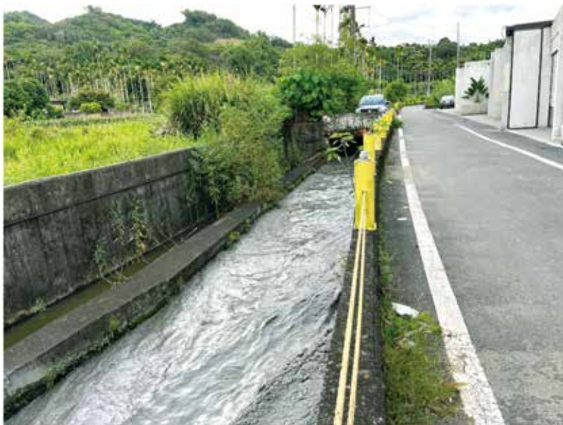
圖一、農業部農田水利署彰化管理處所轄南投縣名間鄉同源圳1k+430m處。
