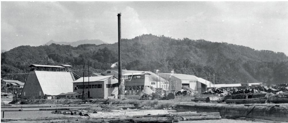
■ 前景為貯木池，從左至右可見燃料倉、鍋爐間（煙囪處）、切片倉，及後方的大製材廠。
