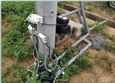
▲以無線傳輸控制器控制電磁閥啟閉，灌溉量上傳雲端系統。
