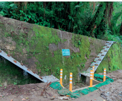
■ 10K+384 上邊坡擋土牆動物通道
