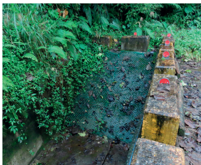
■ 14K+164 集水井左側掛設菱形網
