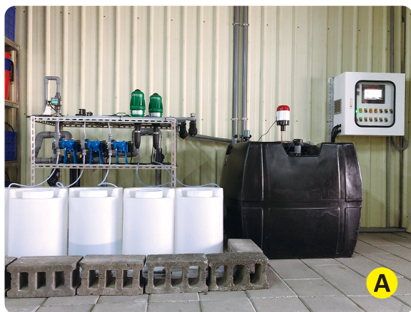
圖5. 自動化水養液噴灌系統(A)應用於文心蘭智慧化生產管理(B)
