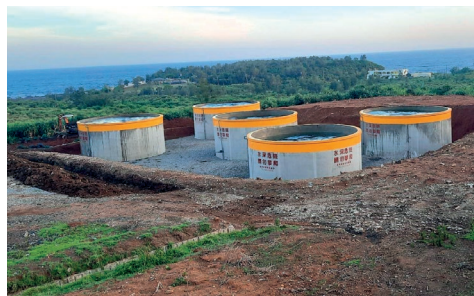
■ 新竹（上）、南投（中）及臺東（下）偏遠山區、離島新建蓄水池。
