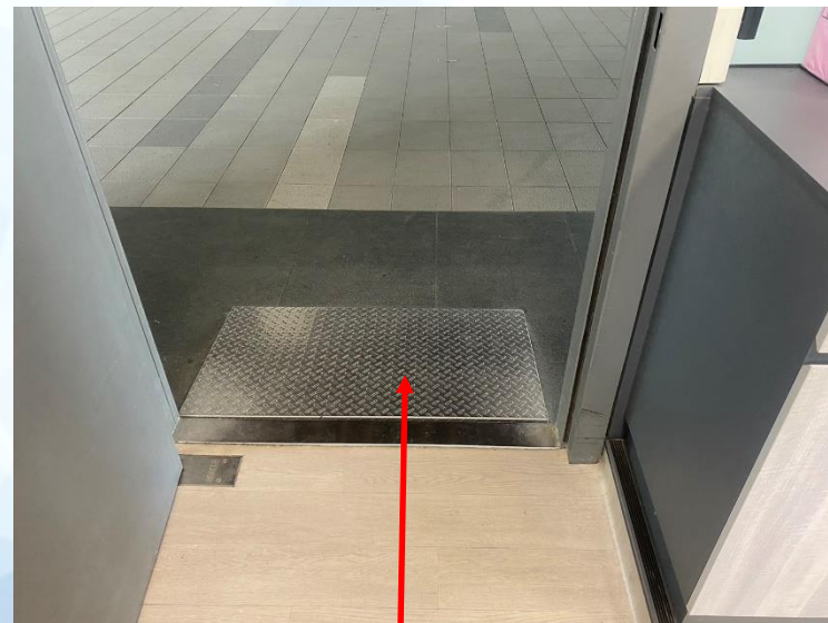
入口處設斜坡道
