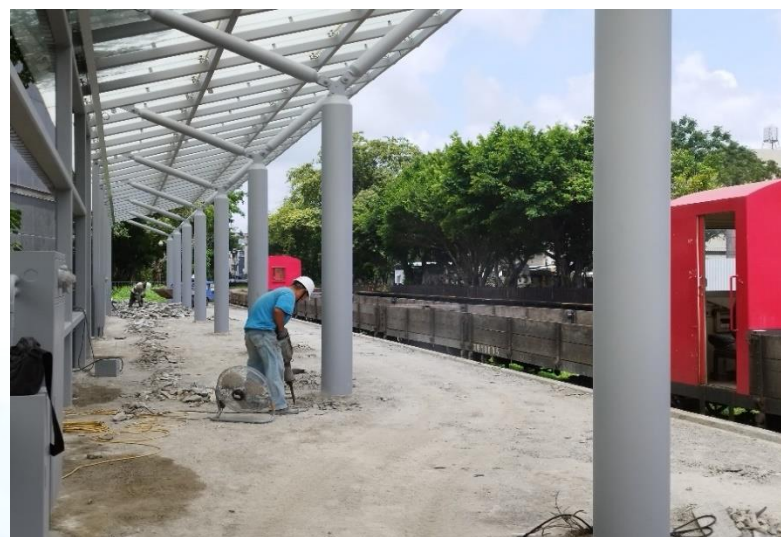
地磚打除重鋪
