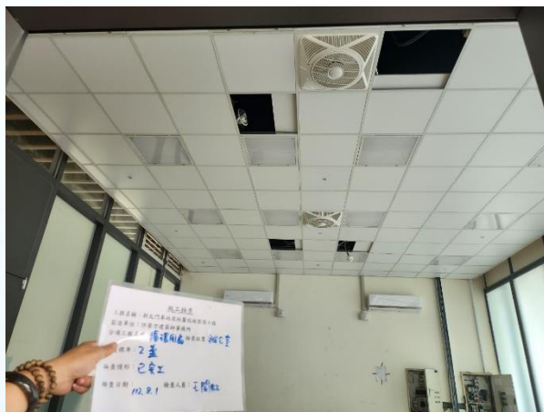
燈具照明工程-循環扇安裝
