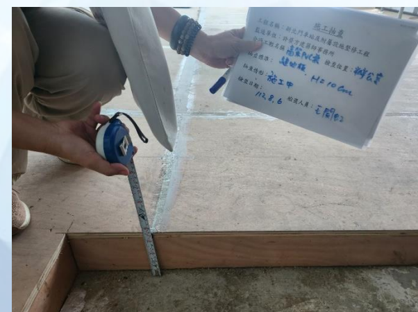
PVC無縫木紋地板工程施工
