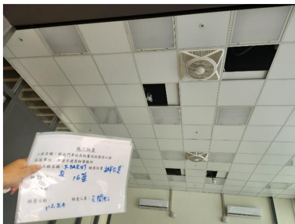
燈具照明工程-T-BAR燈安裝
