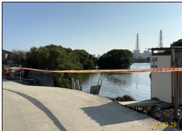
開口部分設置警戒線
