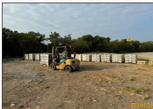
生態疊塊磚小搬運至工區空地
