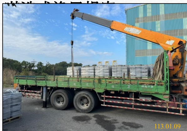
生態疊塊磚運至工區附近空地
