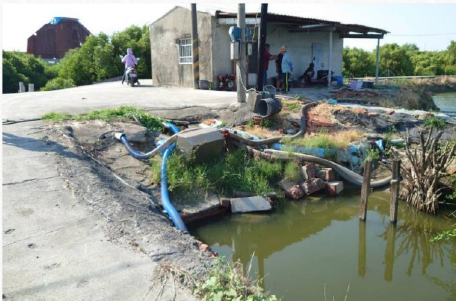
雜生茂密造成地表逕流不易流入渠道。
