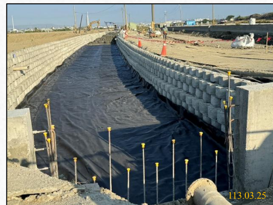
裸露鋼筋放置鋼筋保護套
